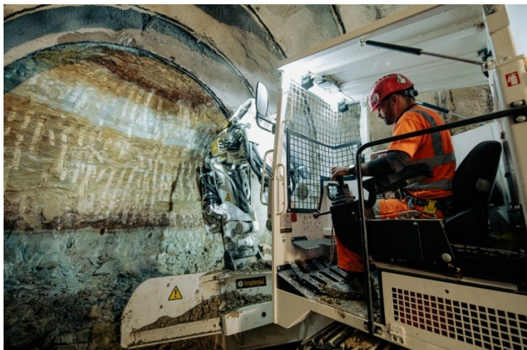
Der maschinelle Vortrieb für den Sicherheitsstollen ist abgeschlossen.
